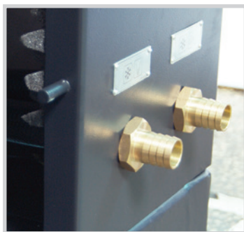
Kühlgerät Vor- und Rücklauf
